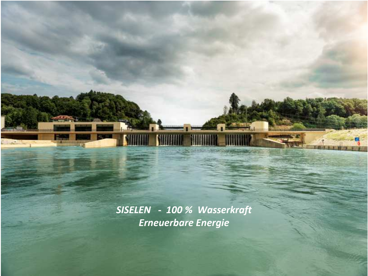
BKW – Wasserkraftwerk Hagneck
